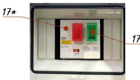
Рисунок 14. Автомат защиты и запуска двигателя.
