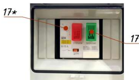
Рисунок 64. Автомат защиты и запуска двигателя.
